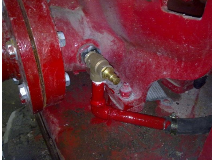
fig-6. casing relief valve
